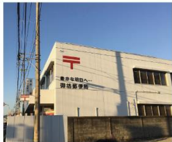
〒マークが設置された
