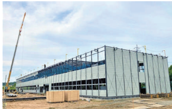
建設中の仮設校舎
