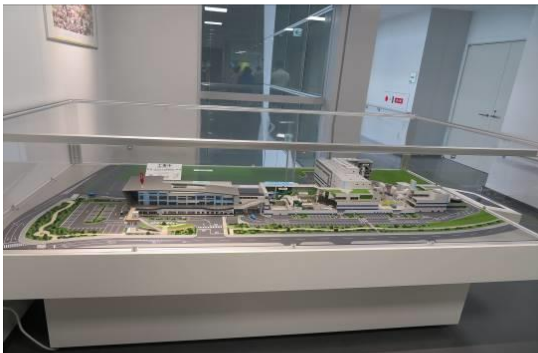
町田市バイオエネルギーセンターの全貌
