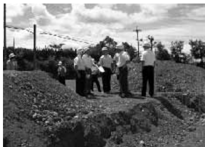
8月22日 浄谷住宅造成工事現場視察
