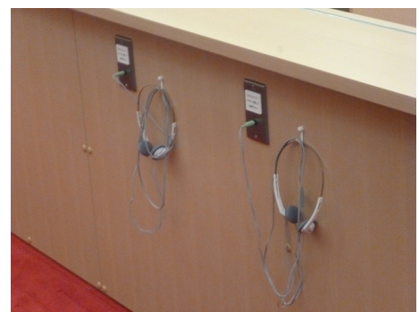
〔磁気ループ補聴システム〕
