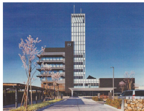
〔長浜市役所（H26年4月完成）〕
