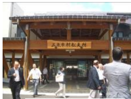
木造の村松支所庁舎
